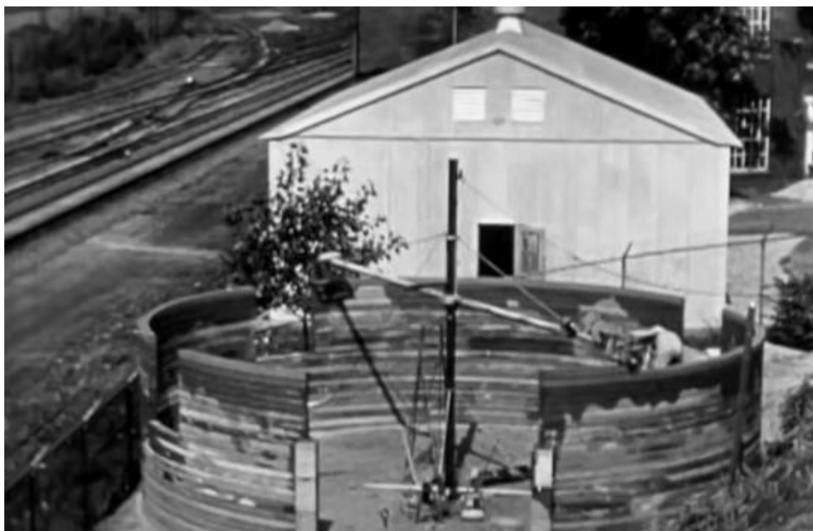
Рис. 1. – Уильям Урошель демонстрирует свою машину для возведения стен, Вальпариосо, штат Индиана [11].
