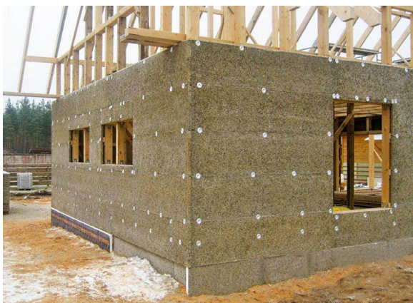
Рис. 1. Использование блоков костробетона.
